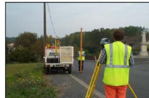
Nivellement de l'antenne
